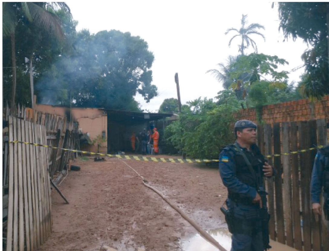
Sinistro. Área interna do imóvel foi completamente destruída pelo fogo.
